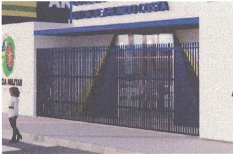
1 Portão de grade de ferro com 2.5m de altura por 6.00m
